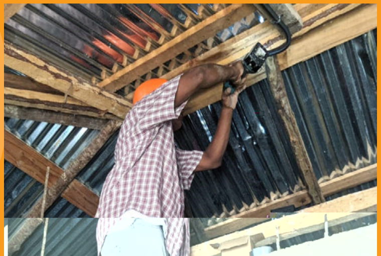
Paneles solares instalados y realización de la electrificación residencial por parte de la DERS del MEMRD.
