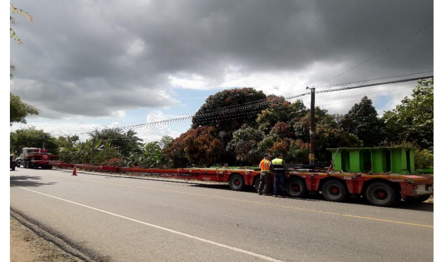
Prueba de Vacío para Transporte y Accesos
